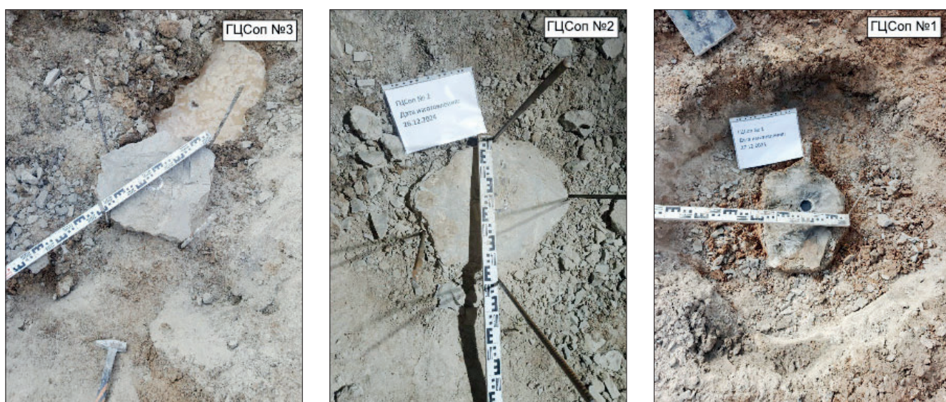
Рис. 5. Контроль поперечного сечения грунтоцементных свай
