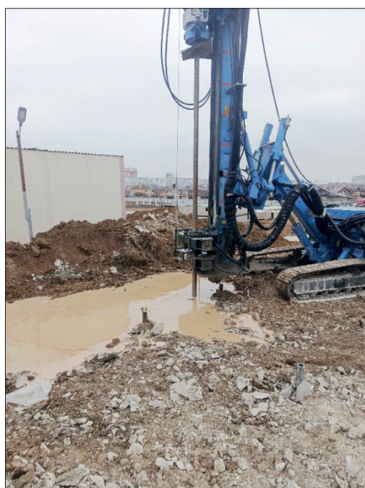
Рис. 7. Схема и общий вид процесса интенсивного замачивания массива просадочного грунта Fig. 7. Scheme and general view of the collapsing soil mass intensive soaking process
