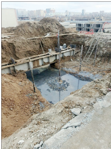
Рис. 8. Схема и общий вид процесса долговременного замачивания грунта Fig. 8. Scheme and general view of the long-term soil soaking process
