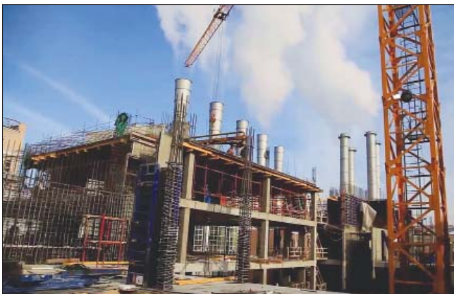
Рис. 9. Работы по устройству надземной части здания
