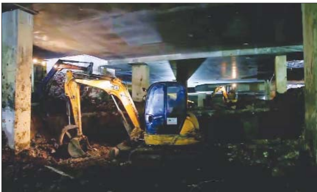
Рис. 7. Эскавация грунта на минус втором уровне малогабаритной техникой
