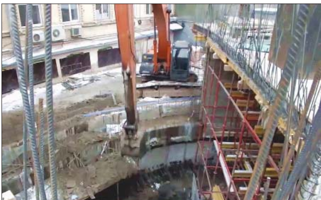
Рис. 8. Эскавация грунта на поверхность
