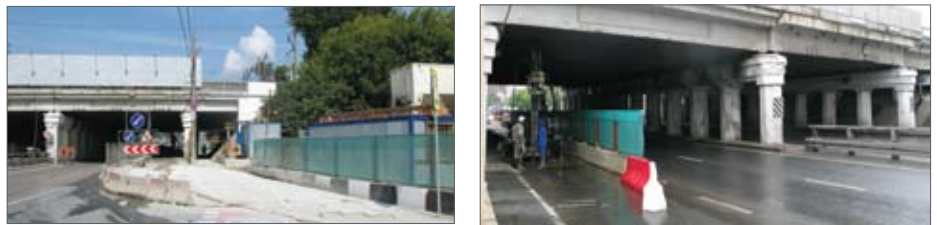
Рис. 5. Организация работ по усилению фундаментов путепровода
