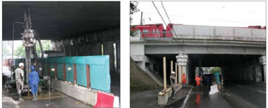
Рис. 4. Производство работ по устройству грунтобетонных элементов
