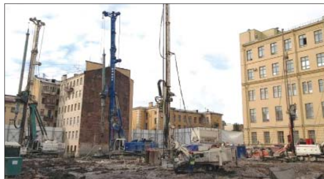
Рис. 1. Работы по устройству подземной части здания в пределах существующей застройки
