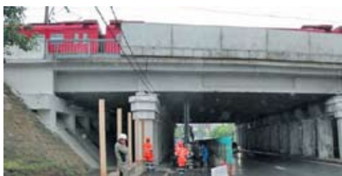
Рис. 4. Общий вид площадки строительства
