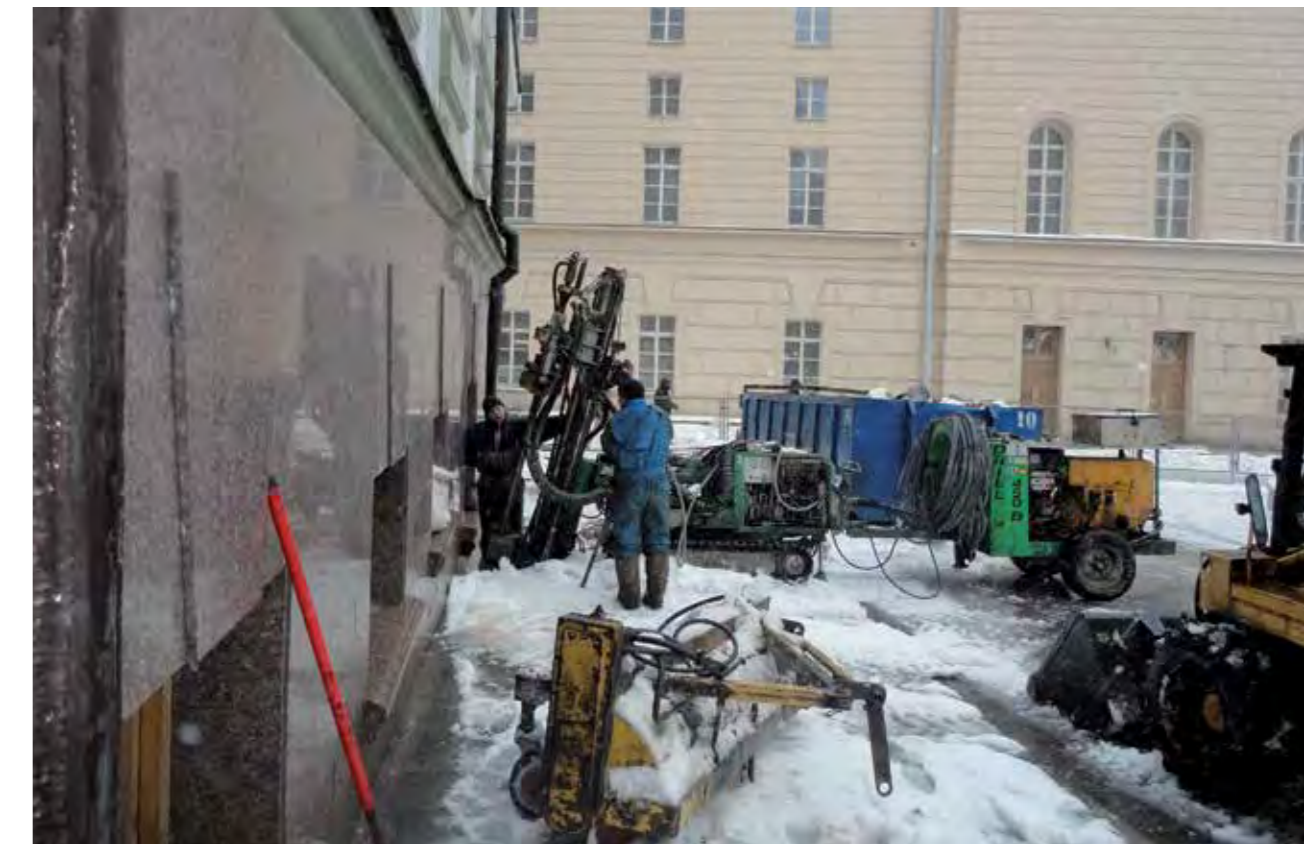
Работы по усилению фундаментов
