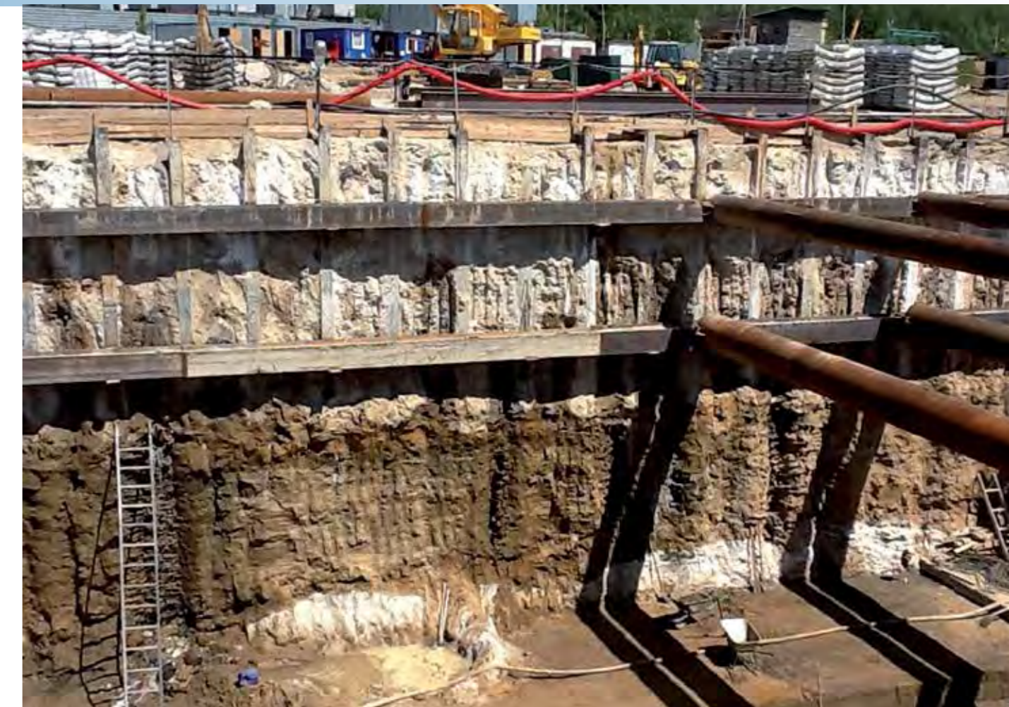
Устройство ограждения котлована грунтоцементными сваями
