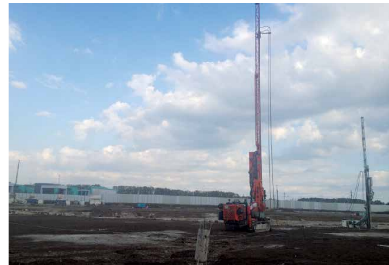
Проведение работ по армированию грунтов
