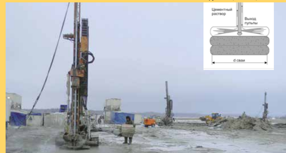
Фото 1. Буровые установки в работе ▲
