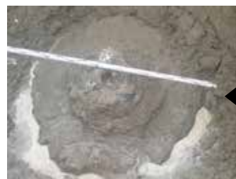
Фото 2. Контрольная свая D=1200 мм
